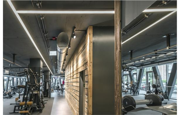
07 Als Basis der Lichtlinien wählten die Planer das PROLED Aluminiumprofil L-Line Standard 24, das direkt auf die Stahlbetondecken montiert wurde.
