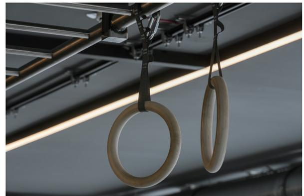
04 Die Lichtlinien sind aus Komponenten von PROLED zusammengestellt; die Abdeckung aus weißem Opal-Kunststoff sorgt für eine gleichmäßige, weiche Lichtverteilung.
